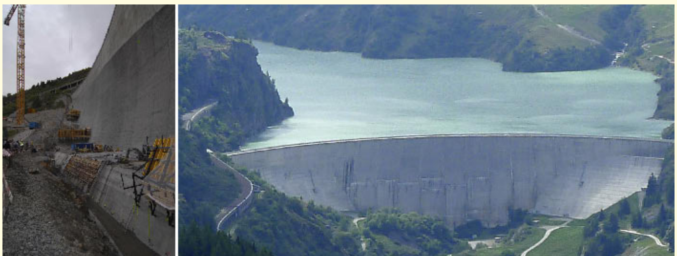
Bild 8. Erdbebenertüchtigung der Bogenstaumauer Les Toules im Wallis durch massiven Beton-Stützkörper auf der linken Talseiten (links) und mit den fertiggestellten Stützkörpern auf beiden Talseiten (rechts).
