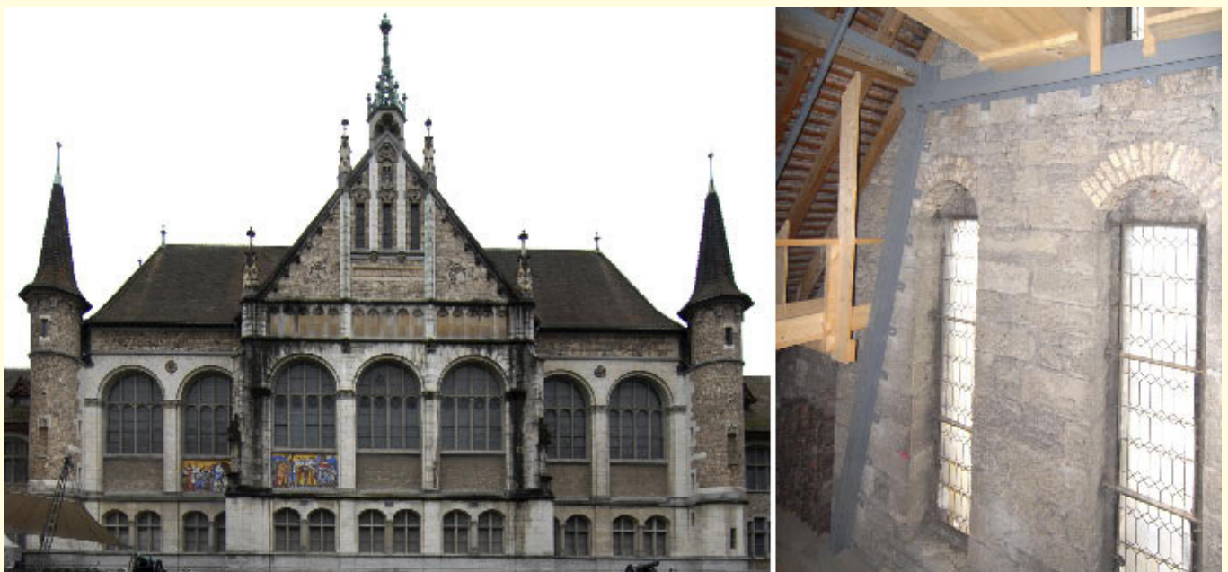
Bild 6. Erdbebenertüchtigung des Landesmuseums in Zürich: Ansicht an die Längsgiebelwand der Ruhmeshalle (links), Stahlrahmen auf der Innenseite der Längsgiebelwand zur Sicherung quer zur Wandebene (rechts).
