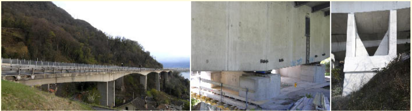
Bild 7. Erdbebenertüchtigung der Zwillingsviadukte von Chillon (links), seismische Isolation mit Blei-Gummilagern auf einer niedrigen Doppelstütze (Mitte), Stahlbeton-Ummantelung einer höheren Doppelstütze (rechts).
