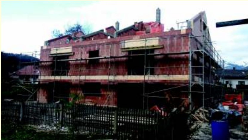
Bild 3. Rohbau Ansicht Südwest
