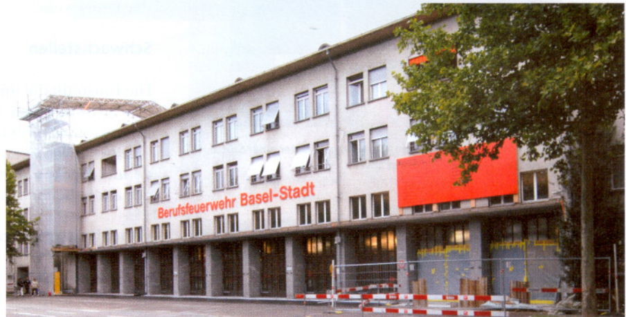
Bild 1. Ansicht an das Feuergebäude während den Ertüchtigungsarbeiten
