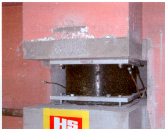
Bild 4. Einbau eines Erdbeben-Gummilagers unter einer Stütze in der Aussenwand des Untergeschosses.
