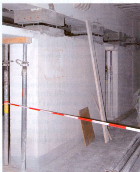
Bild 5. Unter dem stützenfreien Innenbereich werden Gleitlager eingebaut.
