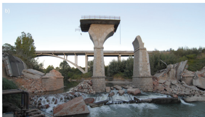
Bild 2. Eingestürzte 7-feldrige Bogenbrücke aus Natursteinmauerwerk über den Rio Claro: Ansicht vor (a) und nach (b) dem Erdbeben.
