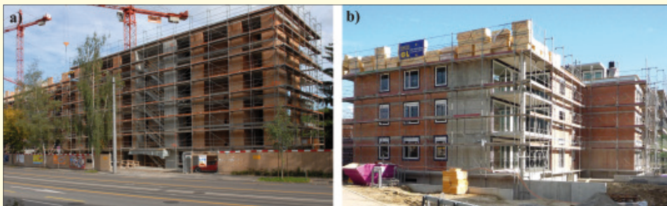
Bild 1. Mehrstöckige Wohnhäuser in der Schweiz mit Stahlbeton- und Mauerwerkswänden (Fotos: T. Wenk)
