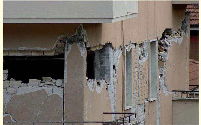
Bild 1. a) Verfüllung der oberen Fuge mit Mörtel und b) Versagen einer Ausfachungswand [1]
