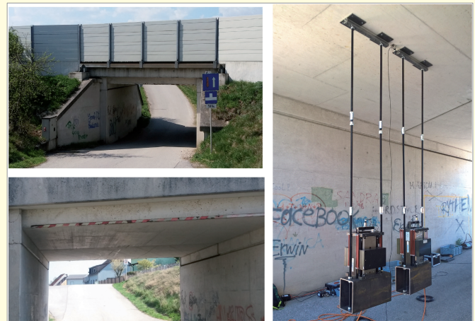
Bild 4. Ansicht des Stahlbetonplattentragwerks und der abgehängten Long Stroke Shaker
