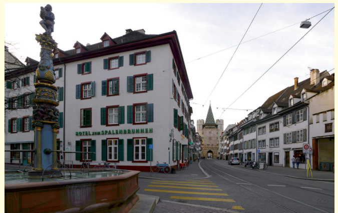
Blick auf die Basler Altstadt mit dem Spalentor
