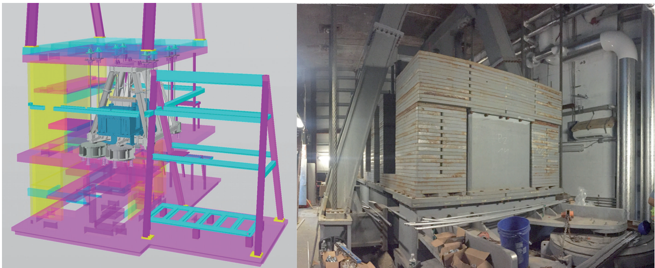
Bild 4. Als Doppelpendel mit Zwischenrahmen ausgeführtes Schwingungstilger-System – links: Modelldarstellung im Bestand – rechts: realisiertes System Abb.: Fa. GERB
